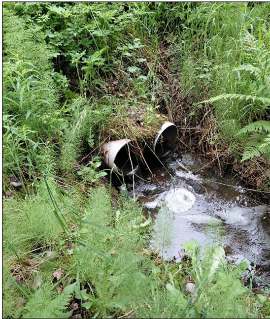
Kuva 12. Strukantien alittavat rummut. Rumpujen kapasiteetti on suhteellisen pieni. Rumpujen koko ja kunto sekä purku-uoman kunto tulee varmistaa jatkosuunnittelussa, jos suunnitellun KTY-alueen hulevedet ohjataan rummun suuntaan. Valokuva Destia Oy 2026, kartta © ScalgoLive 2026.
