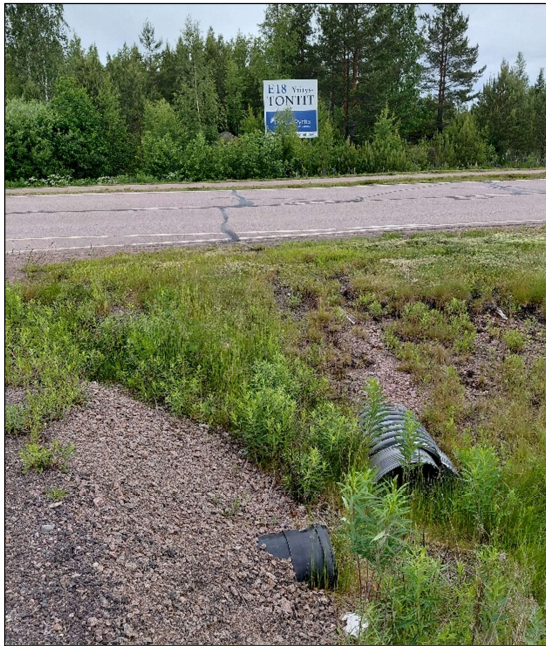
Kuva 11. Maantien 170 (Pyhtääntie) alittava rumpu KTY-korttelialueen pohjoispuolella puuttuu Väyläviraston Velho-rekisteristä. Järjestelmästä löytyy läheinen sivuojarumpu. Maastokäynnin perusteella molempien rumpujen materiaali on muovi. Purkureitin jatkuvuus luoteeseen on epävarma. Valokuva © Destia Oy 2026, kartta © ScalgoLive 2026.
