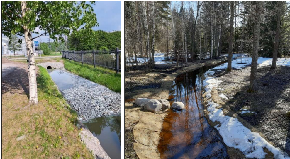
Kuva 17. Vasemmalla havainnollistus ojan yhteyteen toteutetusta väliaikaisesta suotopadosta kiintoaineksen poistamiseksi työmaavesistä. Oikealla eroosiosuojakankaalla suojattu oja. Havainnollistukset © Destia Oy 2024.
