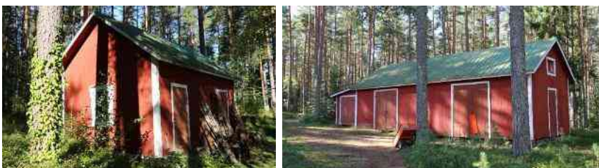
Svedin lännenpuoleinen lomarakennus sekä siihen liittyviä lomarakennuksia.
