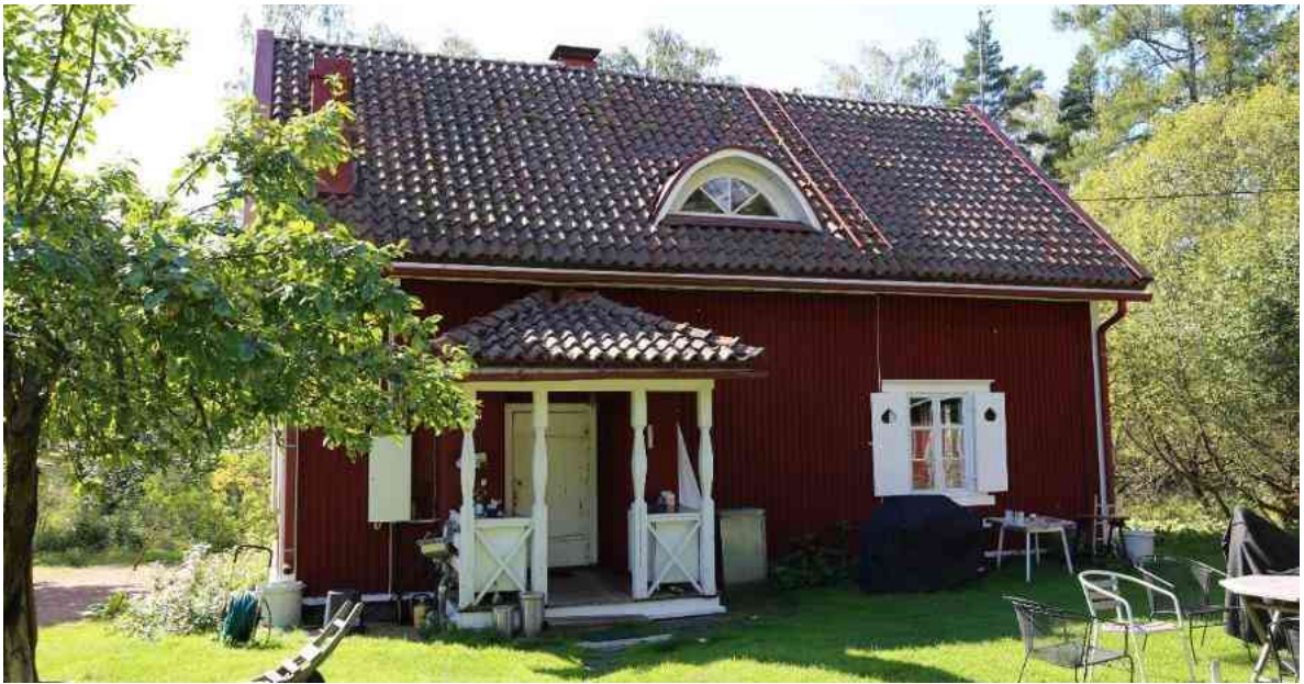
Muuringin julkisivu pohjoiseen.
