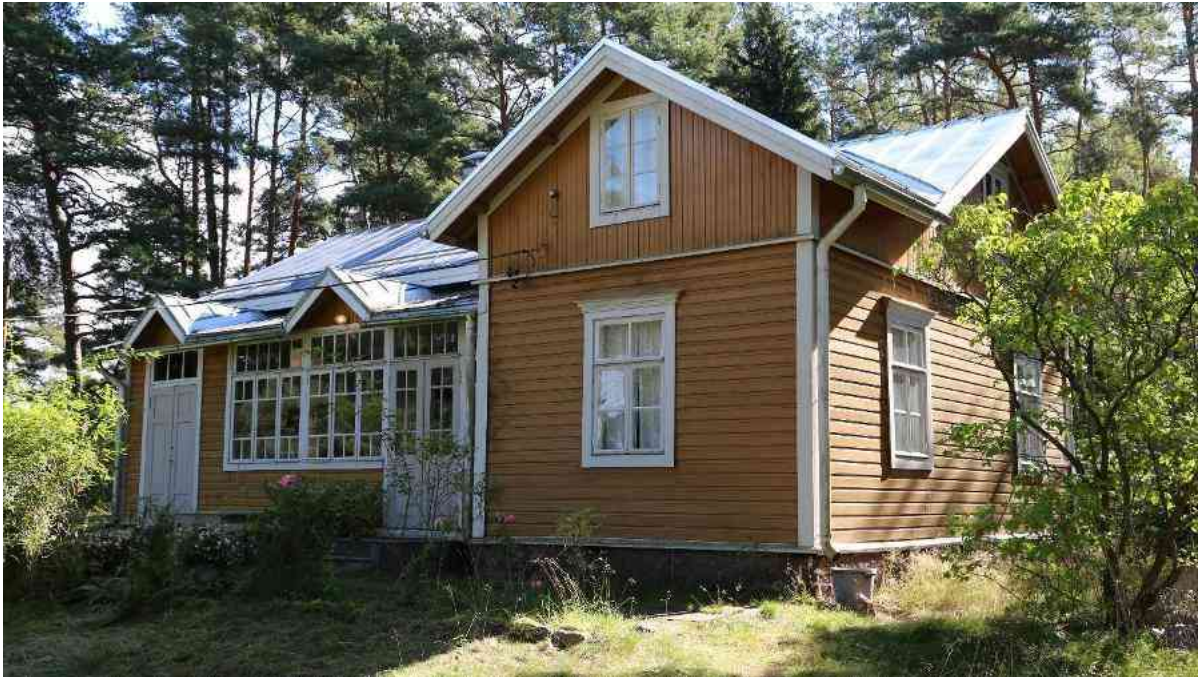
Eskolan julkisivu pohjoiseen.
