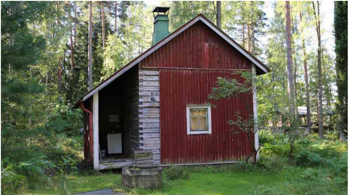
Skinnarin eteläinen lomarakennus.
