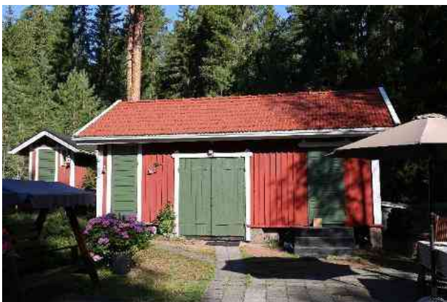
Huvilan pohjoispuoleinen ulkorakennus.
