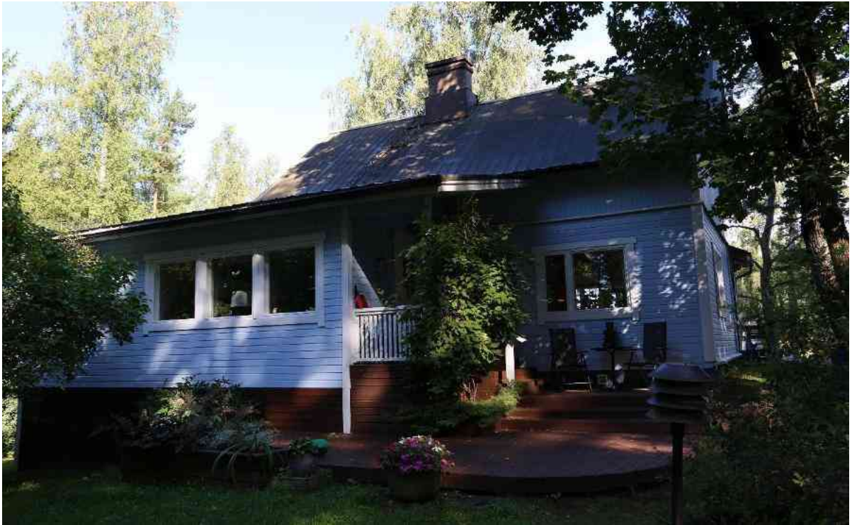
Päärakennuksen pihan puoleinen julkisivu.
