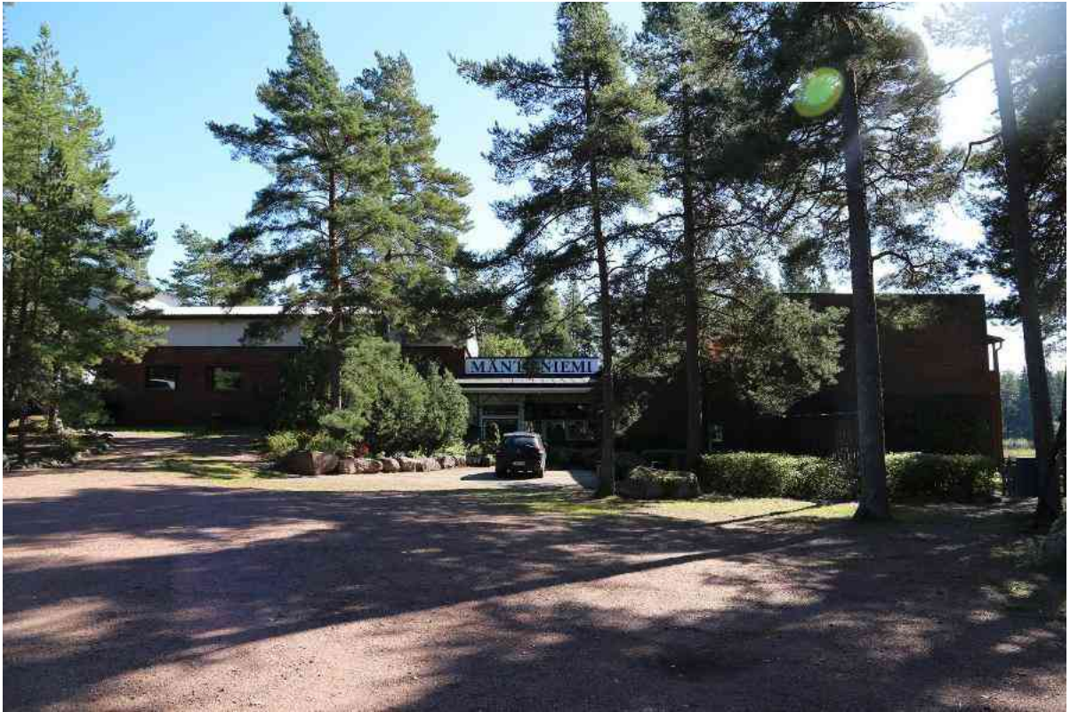
Vasemmalla alkuperäistä rakennusosaa, keskellä pääsisäänkäynti ja oikealla laajennusosa.
