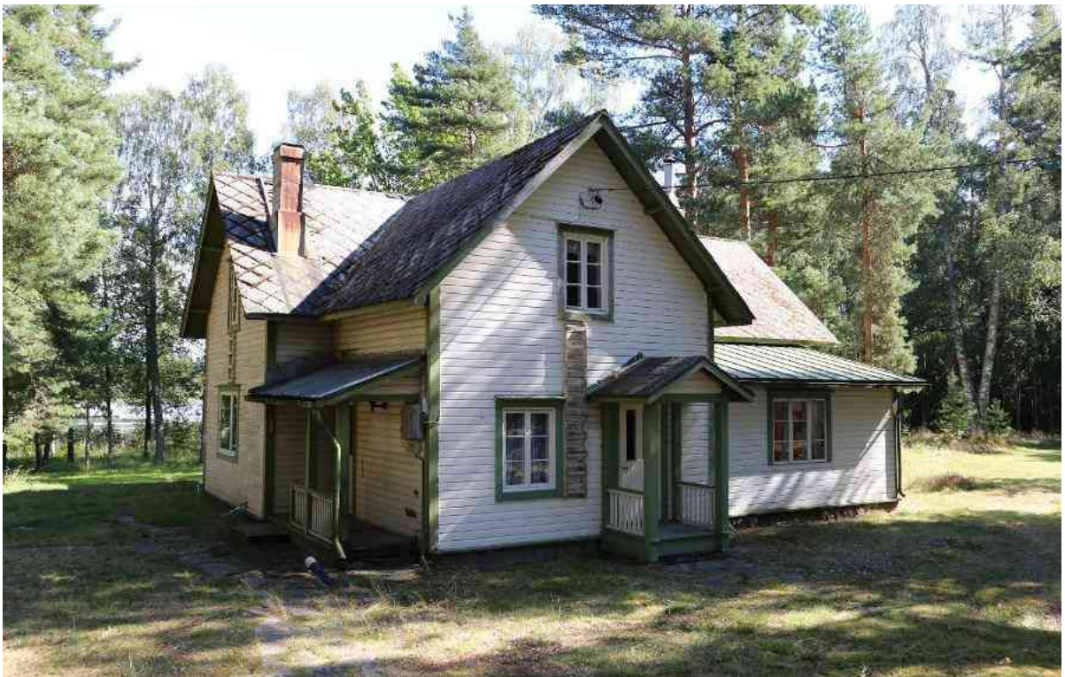
Sommarvikin pohjoisempi päärakennus Sommarvik II.
