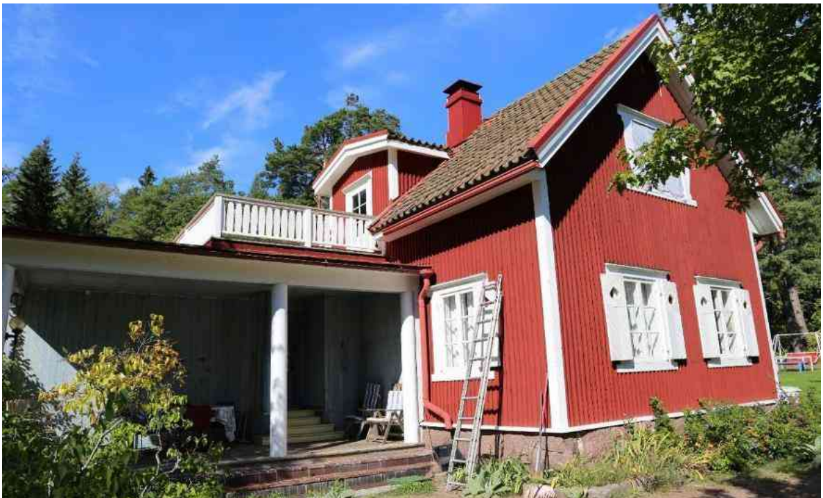
Muuringin julkisivu etelään.
