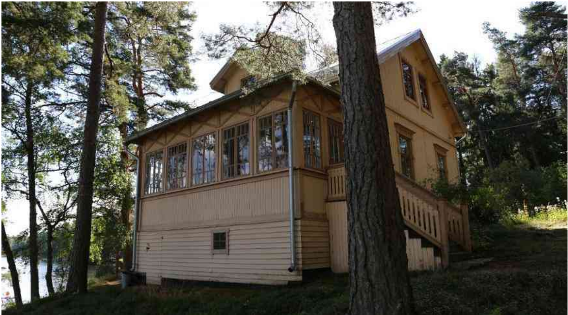
Julkisivu rannan suuntaan.
