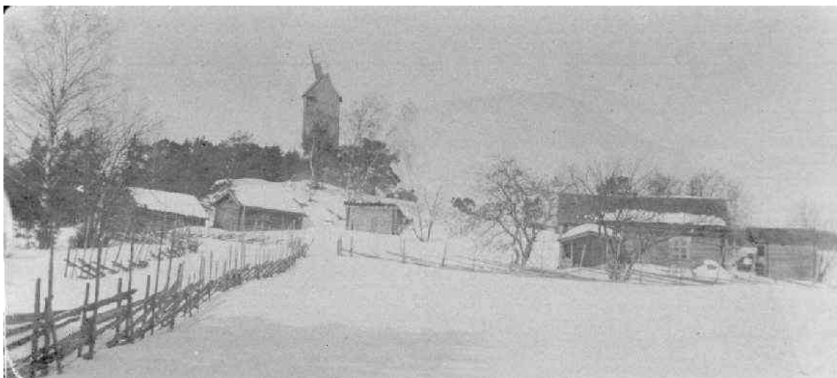
Hinkabölen vanhinta rakennuskantaa edustavat tuulimylly, vanha päärakennus sekä luhtiaitta. Kuva noin vuodelta 1920. (Kuva: Munapirtin saaren kyläyhdistyksen kotisivut)
