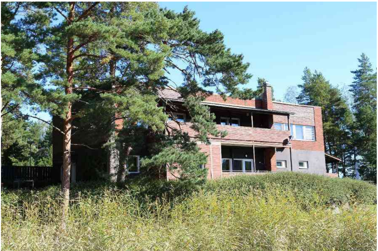
Laajennusosan rannan puoleinen julkisivu.
