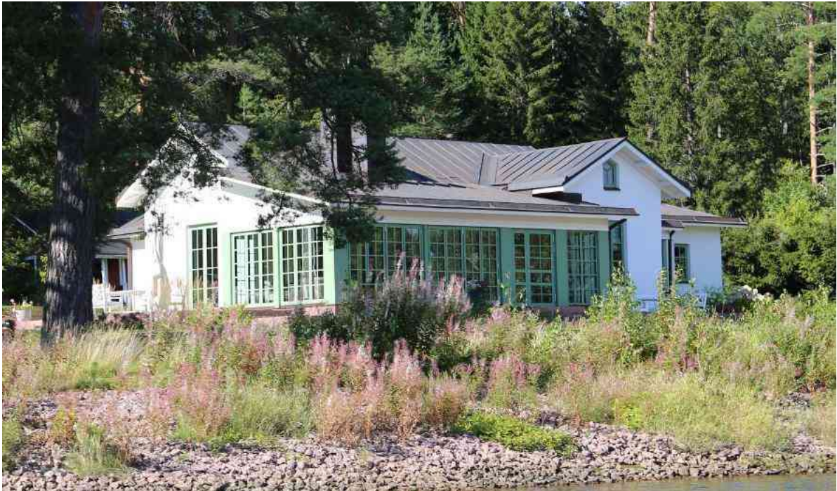
Päärakennuksen julkisivu rannan suuntaan.
