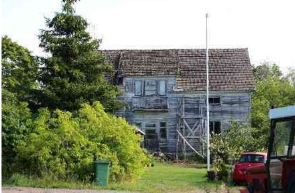
Itäosan rakennuskantaa; Heinlahdentie 123.
