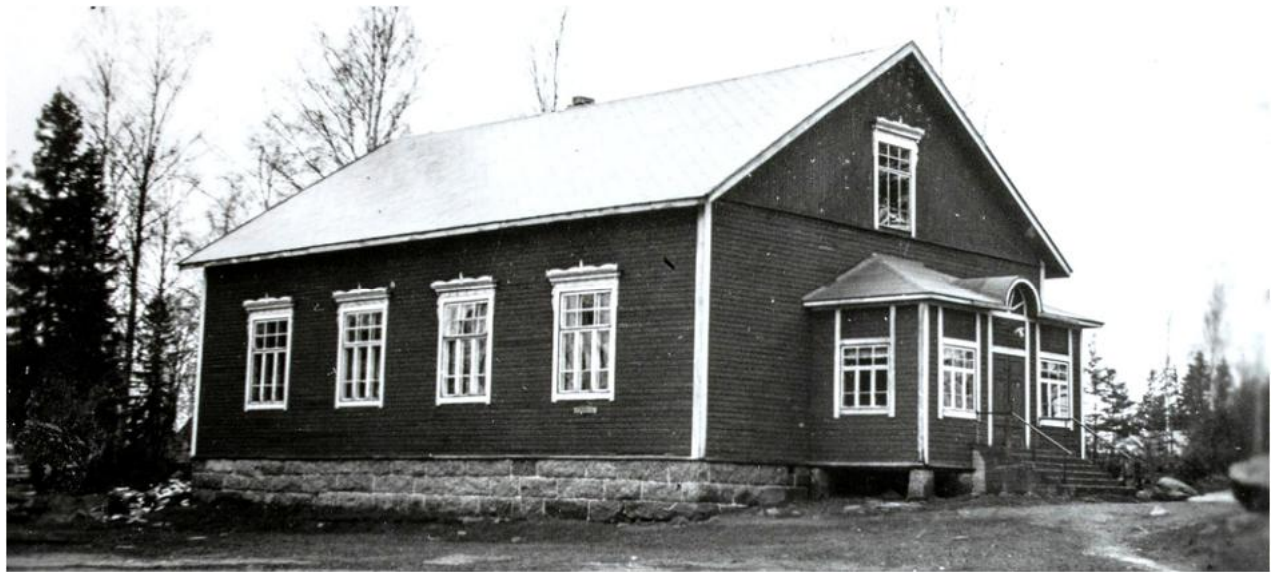
Kuva 3.27. Puolan työväentalo vuonna 1957, rakennusinventoinnin kohde 12 (Työväen Arkisto).
