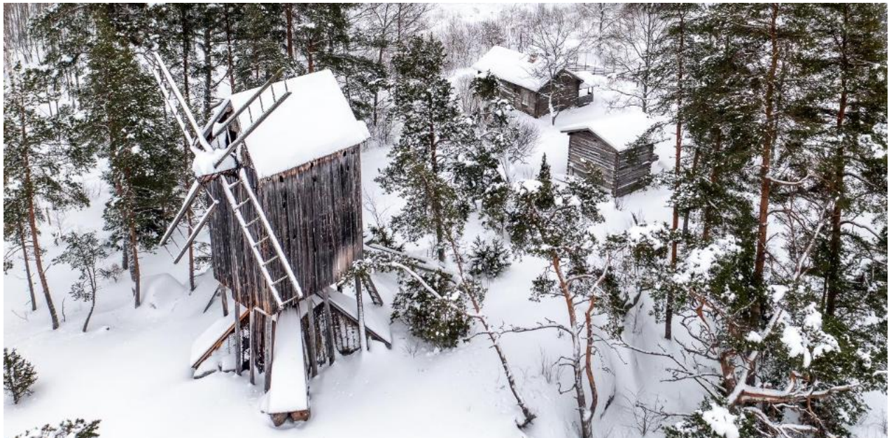
Kuva 3.25. Hinkabölen tuulimylly ja vanha asuinrakennus, rakennusinventoinnin kohteet 3 ja 5 (Carl Svanfält / Pyhtään kunta).
