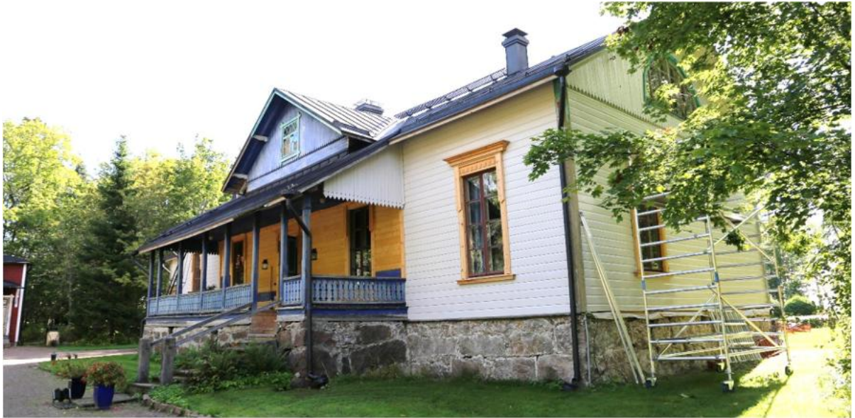
Kuva 3.29. Kiviniemen kartanon päärakennus, rakennusinventoinnin kohde 7.
