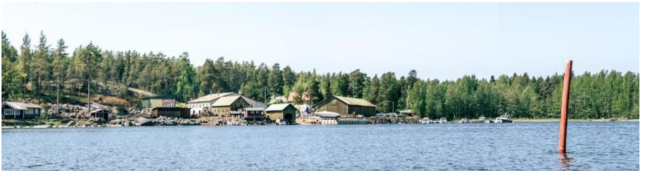
Kuva 3.15. Keihsässalmen veneveistämön rakennuksia (Carl Svanfält / Pyhtään kunta).
